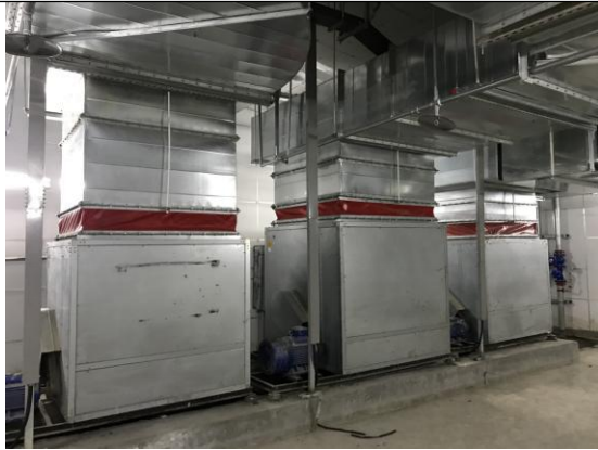
发电机房吸声墙面、坐式减震器
