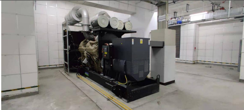
发电机房吸声墙面、坐式减震器
